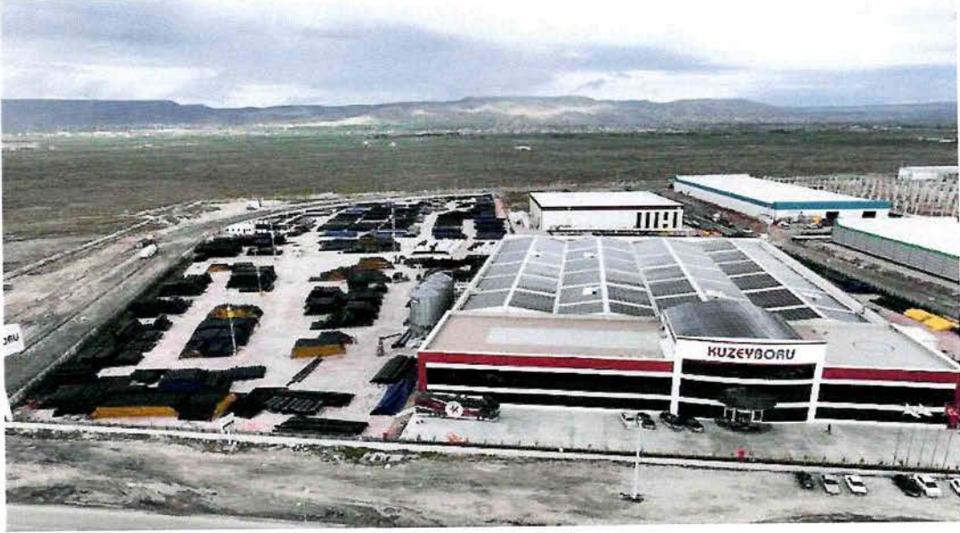
Resim 1: Kuzey Boru Merkez Fabrika Binası
