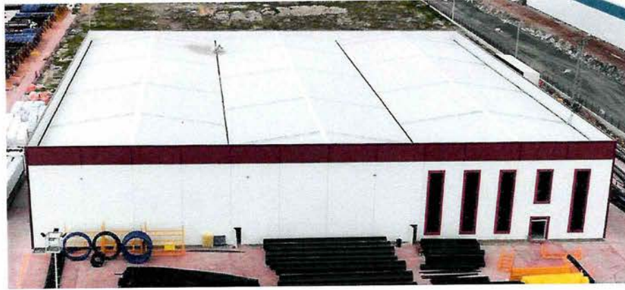
Koruge Boru Üretim Tesisi
